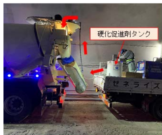
写真-2 現場添加状況
